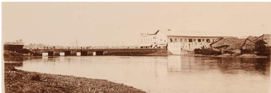
Picha Na 4.1: Daraja Lililokua Likiunganisha Kati ya Mji Mkongwe na Ng'ambo
